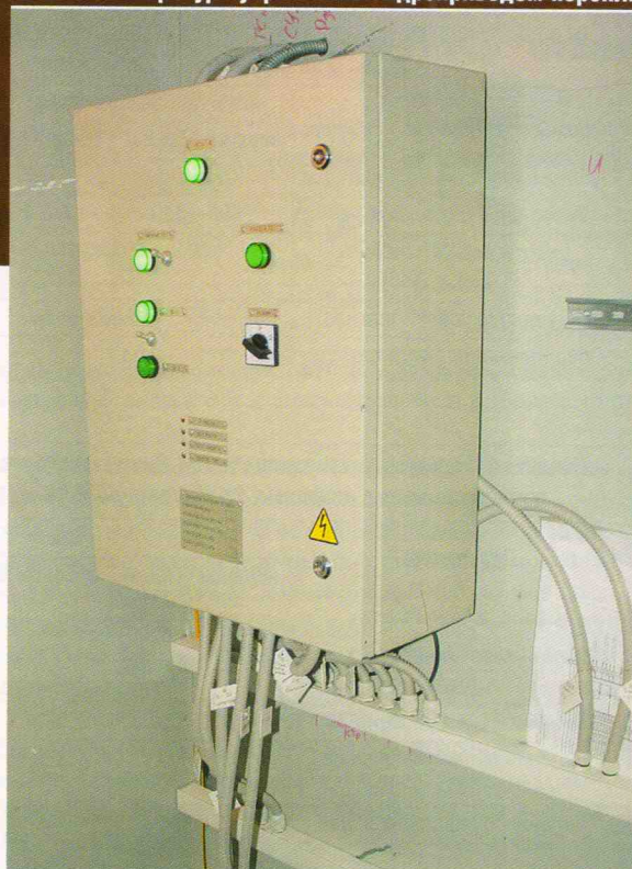
Рис. 6. Аппаратура управления гидроприводом переключателя потоков
